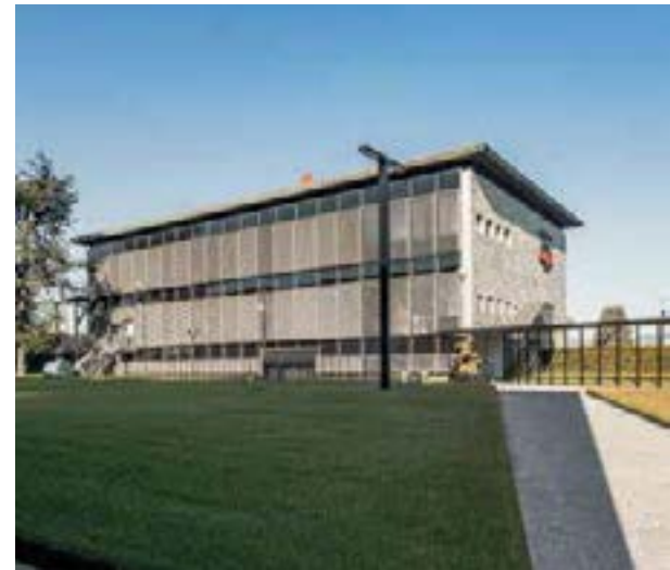
Lo stabilimento principale di Gnutti Transfer a Ospitaletto (BS)
